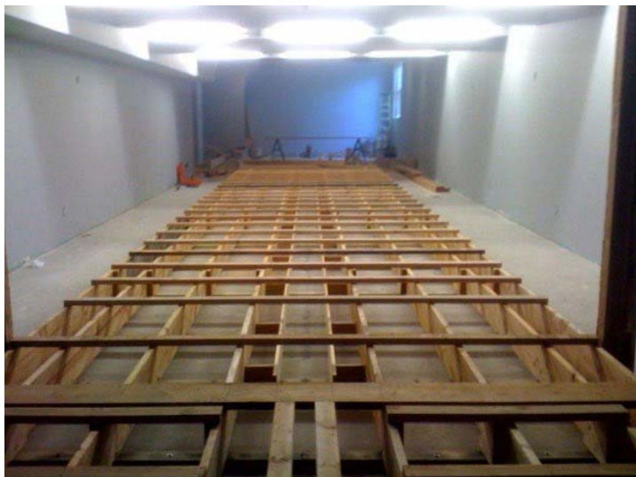
Каркас дорожки (подоснова), построенный на плоском основании.
