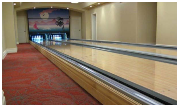
Дорожки для боулинга, построенные на основании с траншеей, возвышаются примерно на 16,5 см над полом.
