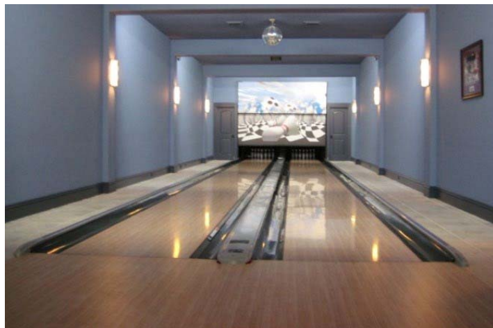
Готовое основание с углублением и боковыми проходами, выведенное в один уровень с поверхностью дорожки.
