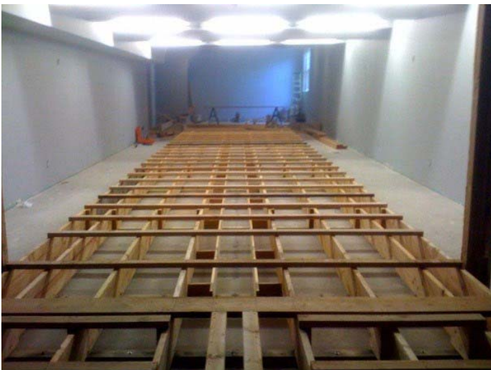
Каркас дорожки (подоснова), построенный на плоском основании.
