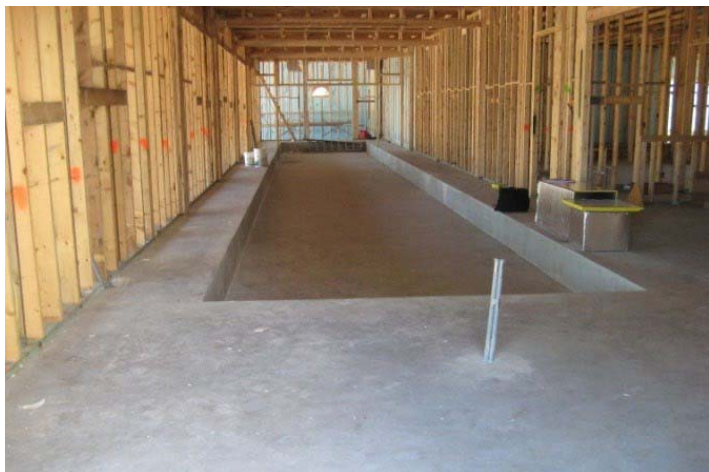
Основание с углублением и магистралью для кабеля на переднем плане.
